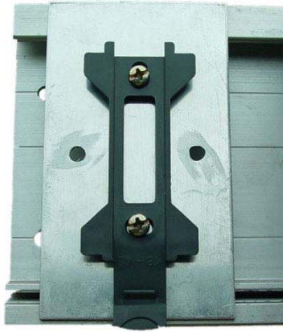
将支架和铝板固定在 S7-300PLC 的导轨上
